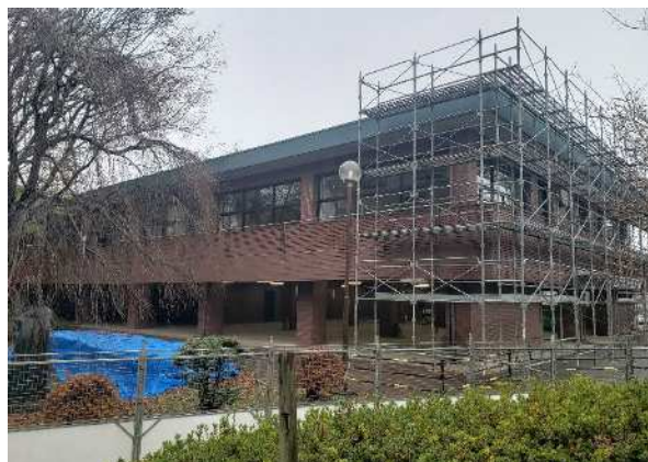
改修工事中的見沼グリーンセンター本館
